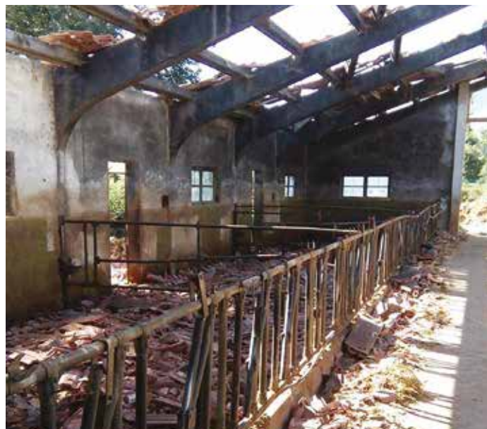
Foto 1. Stalla ad Amatrice, dopo il sisma; le strutture di allevamento erano per il 90% danneggiate.
